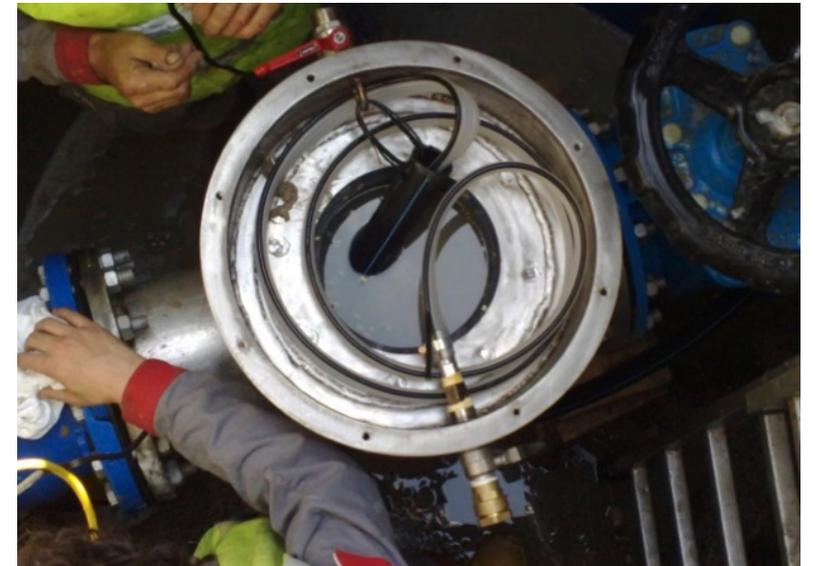
828m et 1106m d'aération dans des sections anaérobies du système d'eaux usées / installation de Trautenstein/ assurent depuis 2002 l'absence d'odeurs et une nette réduction des dommages dus à la corrosion.
