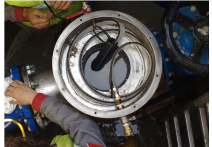
828m und 1106m Belüftung in anaeroben Teilabschnitten des Abwassersystems / Anlage Trautenstein/ sorgen **seit 2002** für Geruchsfreiheit und deutlich reduzierte Schäden durch Korrosion.
